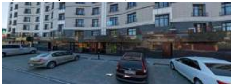
Фото 37 Общий вид оцениваемых помещений.
