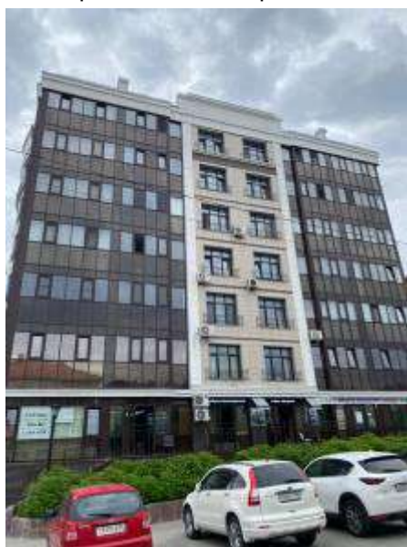
Фото 1. Внешний вид здания
