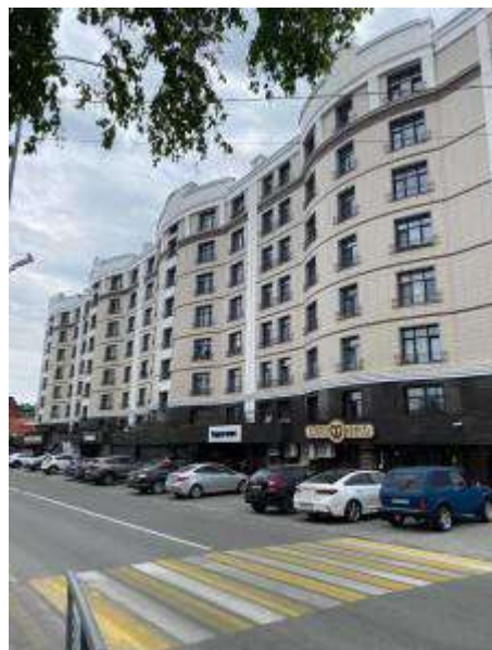
Фото 2. Внешний вид здания
