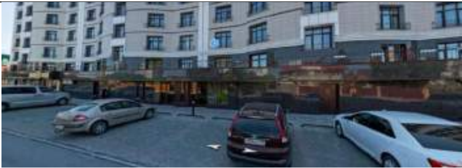
Фото 35 Общий вид оцениваемых помещений.
