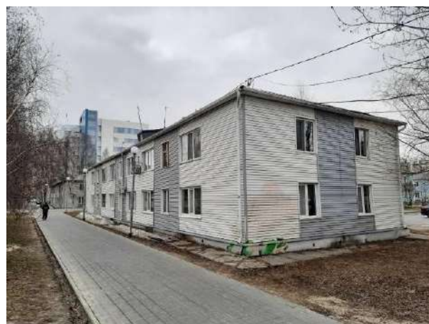
Фото. 2. Жилой дом по адресу: г. Ханты-Мансийск, ул. Мира, д. 23
