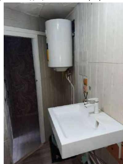
Фото. 23. Внутренний вид оцениваемой квартиры
