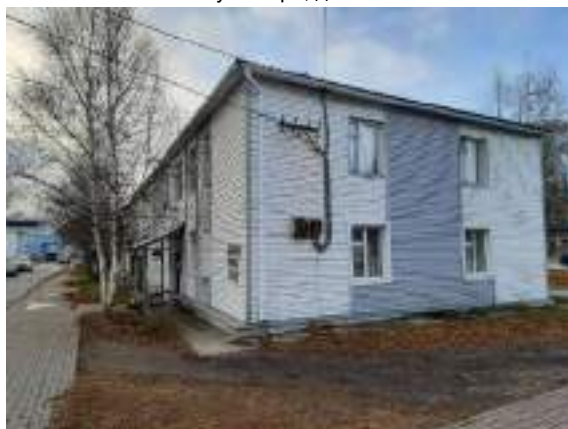
Фото. 4. Жилой дом по адресу: г. Ханты-Мансийск, ул. Мира, д. 23
