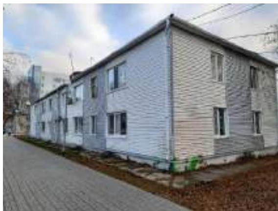
Фото. 2. Жилой дом по адресу: г. Ханты-Мансийск, ул. Мира, д. 23
