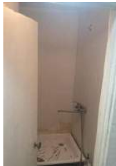
Фото. 31. Внутренний вид квартиры по адресу: г. Ханты-Мансийск, Маяковского, д. 4
