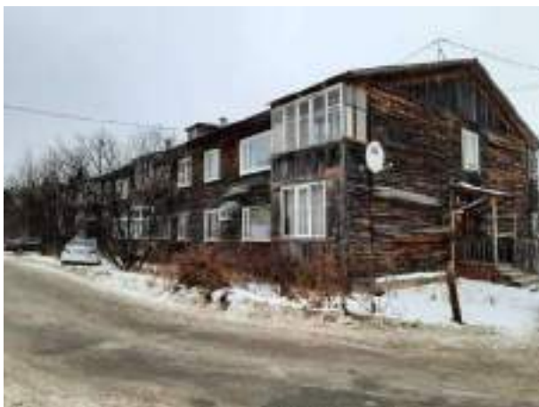
Фото. 1. Жилой дом по адресу: г. Ханты-Мансийск, ул. Чехова, д. 66а
