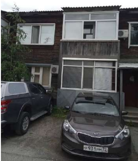
Фото. 3. Жилой дом по адресу: г. Ханты-Мансийск, ул. Чехова, д. 66а
