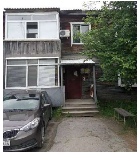
Фото. 4. Жилой дом по адресу: г. Ханты-Мансийск, ул. Чехова, д. 66а
