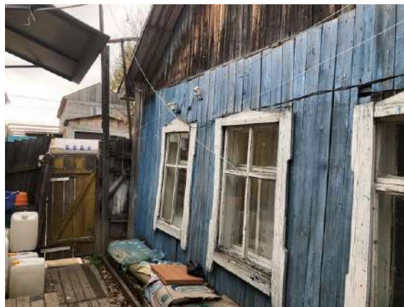
Фото 2. Общий вид жилого дома.
