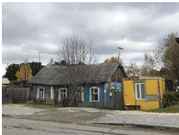
Фото 1. Общий вид жилого дома.
