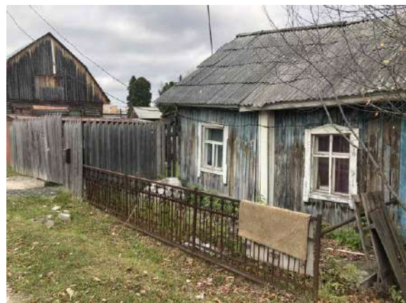
Фото 3. Общий вид жилого дома.
