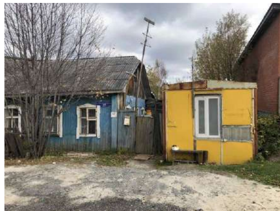
Фото 4. Общий вид жилого дома.
