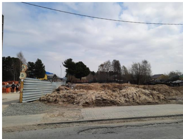
Фото 2. Общий вид земельного участка с кадастровым номером 86:12:0101089:813.
