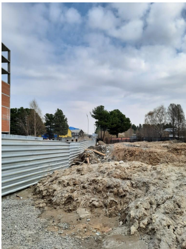
Фото 1. Общий вид земельного участка с кадастровым номером 86:12:0101089:813.
