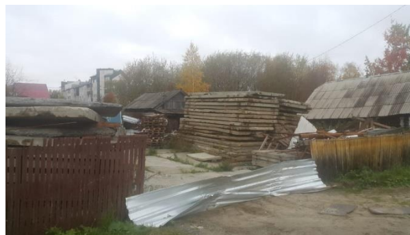
Фото 2. Общий вид земельного участка с кадастровым номером 86:12:0101058:6.
