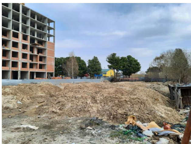
Фото 3. Общий вид земельного участка с кадастровым номером 86:12:0101089:385.
