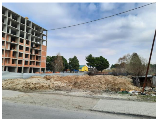
Фото 4. Общий вид земельного участка с кадастровым номером 86:12:0101089:385.
