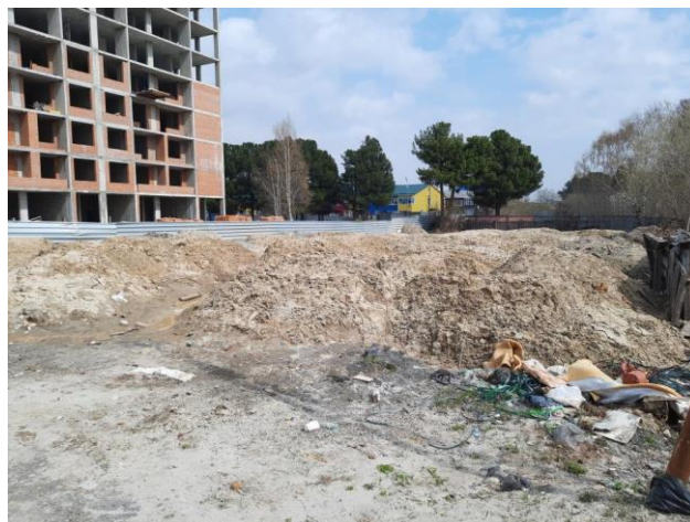
Фото 2. Общий вид земельного участка с кадастровым номером 86:12:0101089:385.
