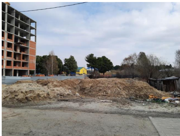
Фото 1. Общий вид земельного участка с кадастровым номером 86:12:0101089:385.
