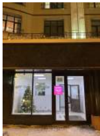
Фото 4. Внешний вид помещений
