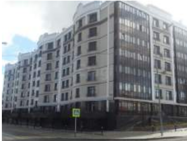
Фото 14 Общий вид жилого дома, в котором находятся оцениваемые помещения
