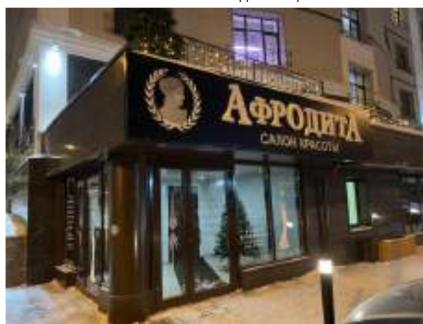
Фото 6. Внешний вид помещений
