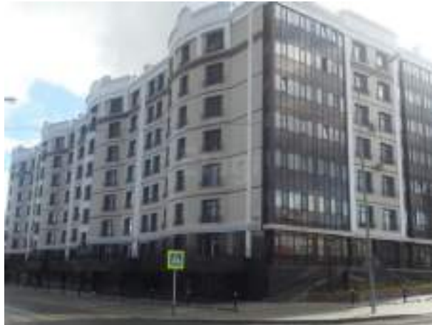
Фото 16 Общий вид жилого дома, в котором находятся оцениваемые помещения
