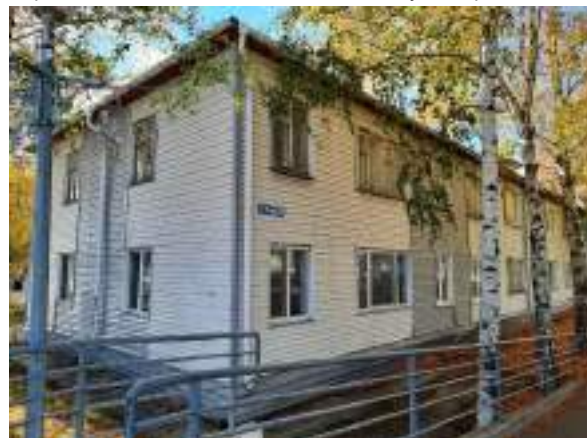
Фото. 15. Жилой дом по адресу: г. Ханты-Мансийск, ул. Мира, д. 25
