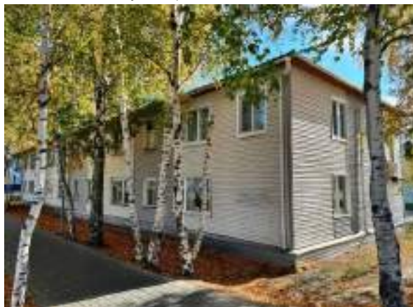
Фото. 14. Жилой дом по адресу: г. Ханты-Мансийск, ул. Мира, д. 25
