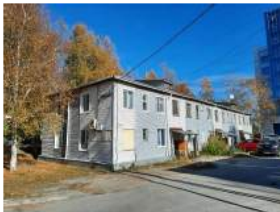
Фото. 17. Жилой дом по адресу: г. Ханты-Мансийск, ул. Мира, д. 25
