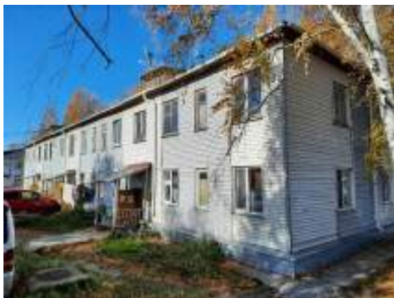
Фото. 16. Жилой дом по адресу: г. Ханты-Мансийск, ул. Мира, д. 25
