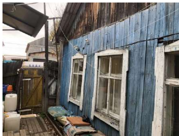
Фото 2. Общий вид жилого дома.
