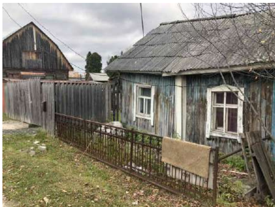
Фото 3. Общий вид жилого дома.
