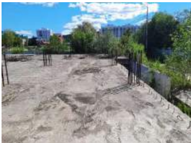
Фото 17. Общий вид объекта незавершенного строительства кадастровый (или условный) номер: 86:12:0101059:30
