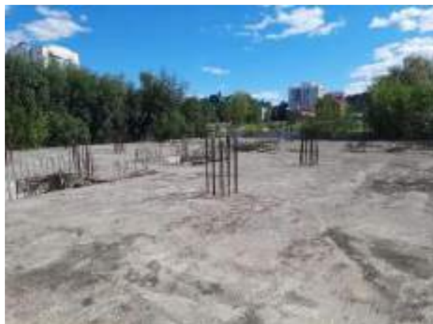
Фото 18. Общий вид объекта незавершенного строительства кадастровый (или условный) номер: 86:12:0101059:30
