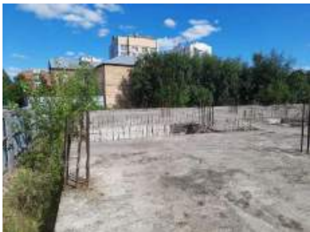
Фото 19. Общий вид объекта незавершенного строительства кадастровый (или условный) номер: 86:12:0101059:30
