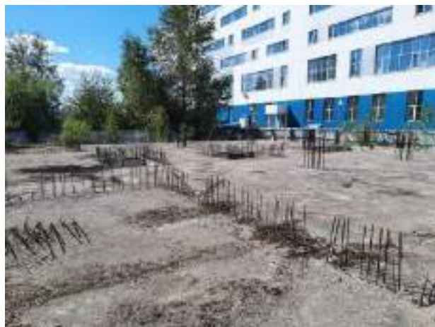
Фото 16. Общий вид объекта незавершенного строительства кадастровый (или условный) номер: 86:12:0101059:30
