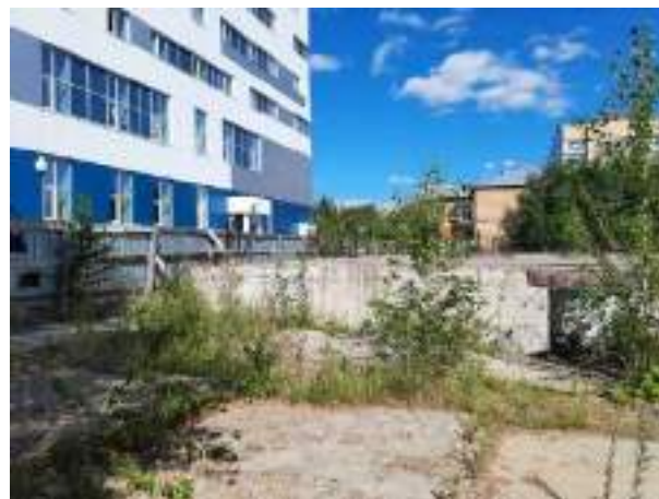
Фото 24. Общий вид объекта незавершенного строительства кадастровый (или условный) номер: 86:12:0101059:30
