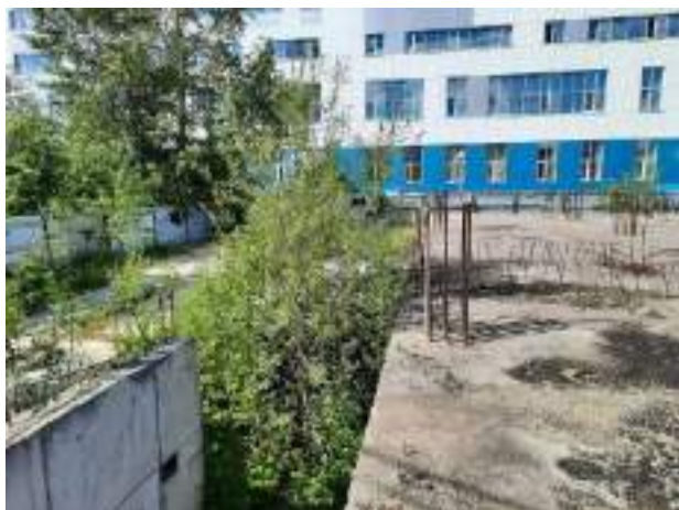
Фото 13. Общий вид объекта незавершенного строительства кадастровый (или условный) номер: 86:12:0101059:30
