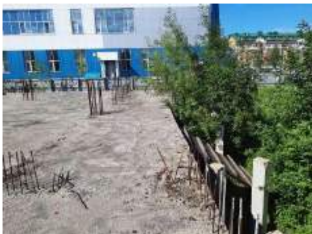
Фото 15. Общий вид объекта незавершенного строительства кадастровый (или условный) номер: 86:12:0101059:30
