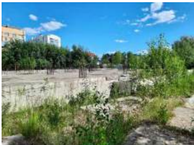
Фото 21. Общий вид объекта незавершенного строительства кадастровый (или условный) номер: 86:12:0101059:30
