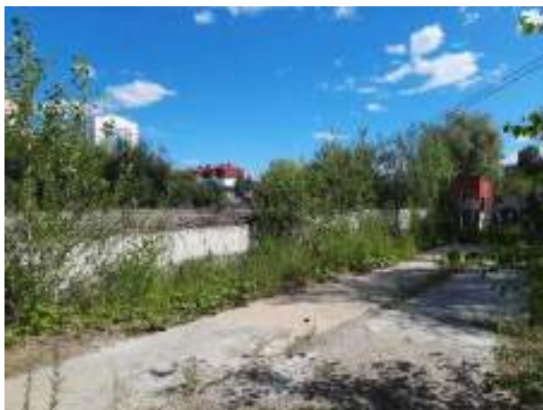
Фото 23. Общий вид объекта незавершенного строительства кадастровый (или условный) номер: 86:12:0101059:30
