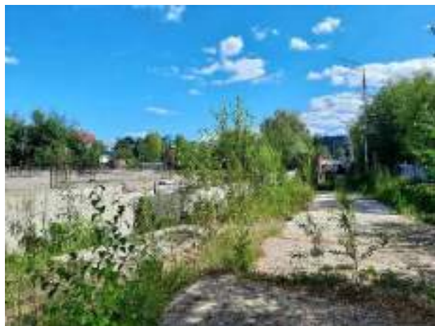
Фото 20. Общий вид объекта незавершенного строительства кадастровый (или условный) номер: 86:12:0101059:30
