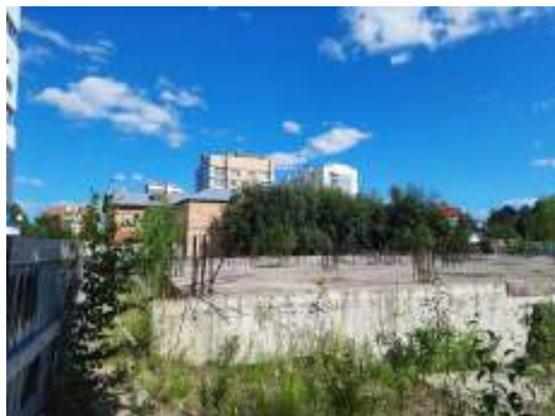
Фото 22. Общий вид объекта незавершенного строительства кадастровый (или условный) номер: 86:12:0101059:30
