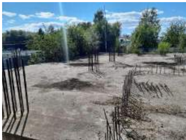
Фото 14. Общий вид объекта незавершенного строительства кадастровый (или условный) номер: 86:12:0101059:30
