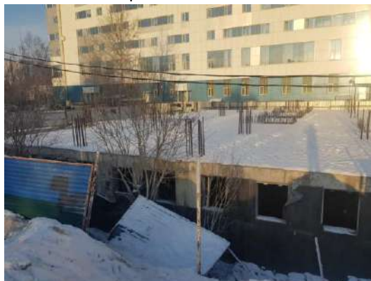
Фото 9. Общий вид объекта незавершенного строительства кадастровый (или условный) номер: 86:12:0101059:30
