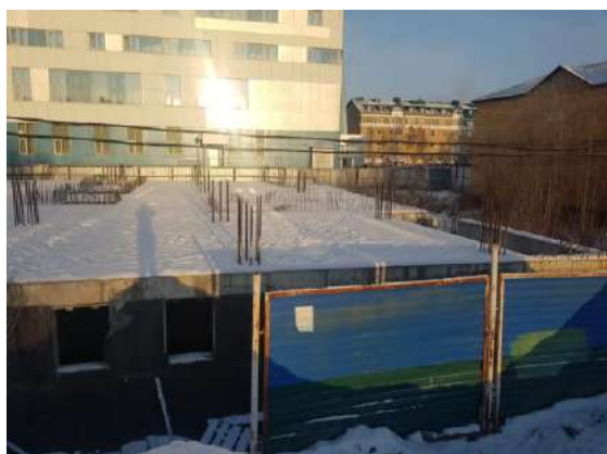
Фото 10. Общий вид объекта незавершенного строительства кадастровый (или условный) номер: 86:12:0101059:30
