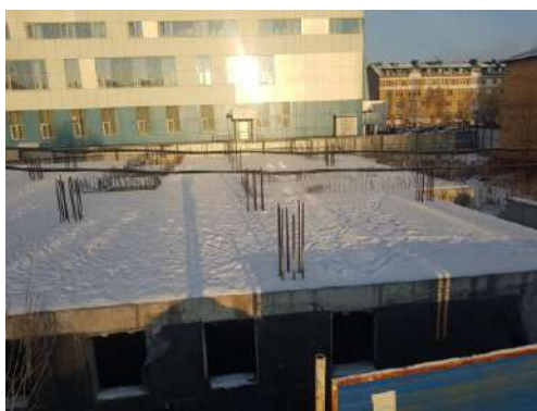
Фото 12. Общий вид объекта незавершенного строительства кадастровый (или условный) номер: 86:12:0101059:30
