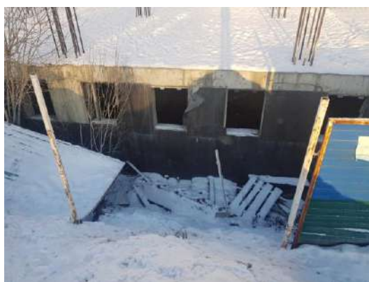
Фото 11. Общий вид объекта незавершенного строительства кадастровый (или условный) номер: 86:12:0101059:30
