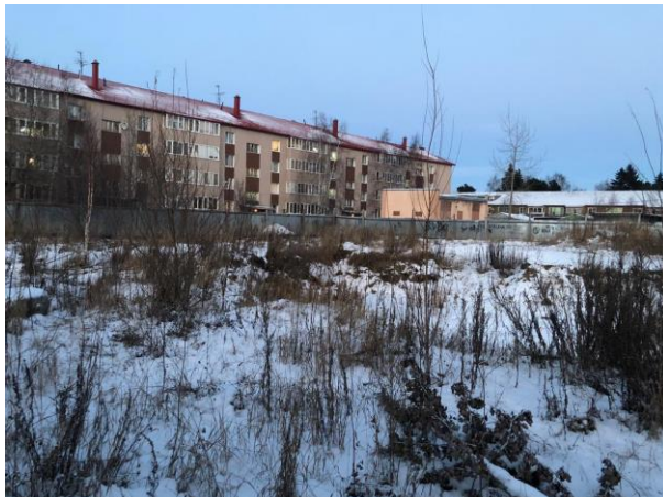
Фото №2. Общий вид земельного участка с кадастровым № 86:12:0101089:542
