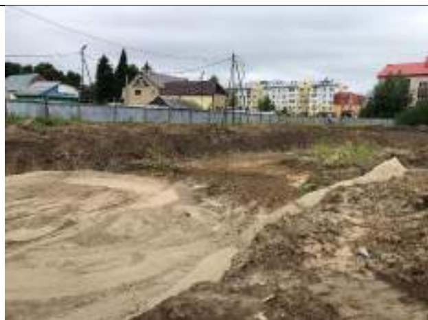
Фото 2. Вид земельного участка, отсыпка
