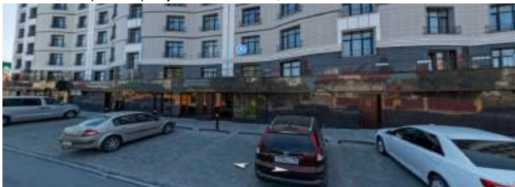
Фото 15 Общий вид оцениваемых помещений.
