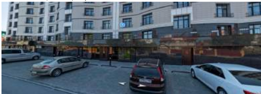
Фото 13 Общий вид оцениваемых помещений.
