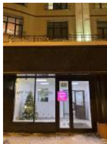
Фото 4. Внешний вид помещений
