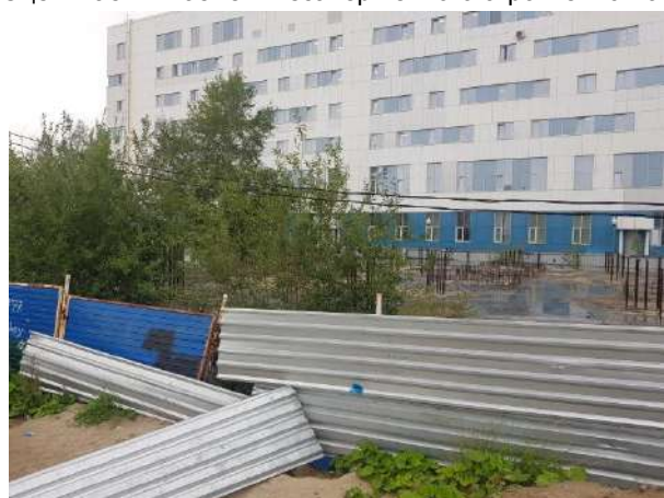
Фото 7. Общий вид объекта незавершенного строительства кадастровый (или условный) номер: 86:12:0101059:30
