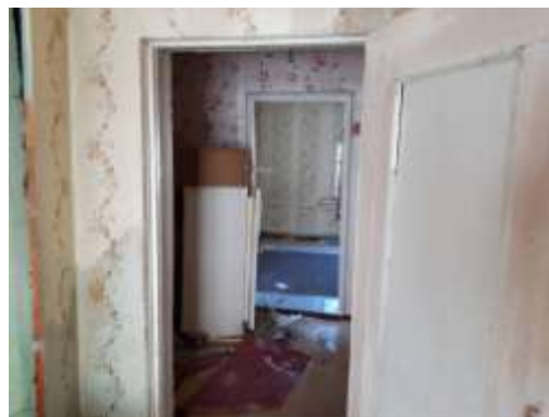
Фото 8. Внутренний вид жилого дома, кадастровый номер: 86:12:0000000:1065
