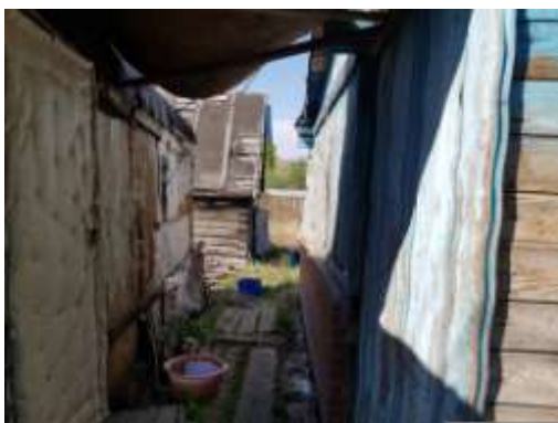
Фото 11. Внутренний вид жилого дома, кадастровый номер: 86:12:0000000:1065
