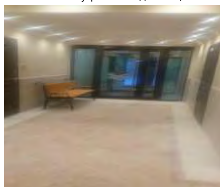
Фото 12. Внутренний вид помещений
