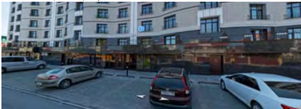
Фото 13 Общий вид оцениваемых помещений.
