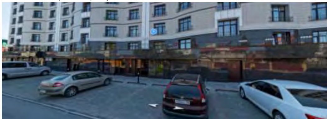
Фото 15 Общий вид оцениваемых помещений.
