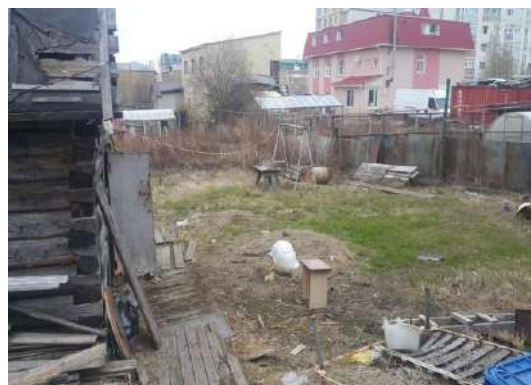
Фото 2. Общий вид земельного участка, кадастровый номер: 86:12:0101059:10
