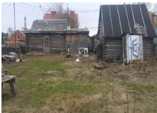
Фото 1. Общий вид земельного участка, кадастровый номер: 86:12:0101059:10
