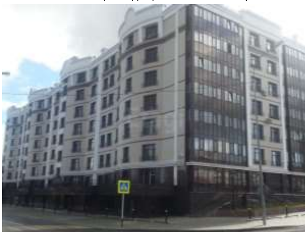
Фото 14 Общий вид жилого дома, в котором находятся оцениваемые помещения
