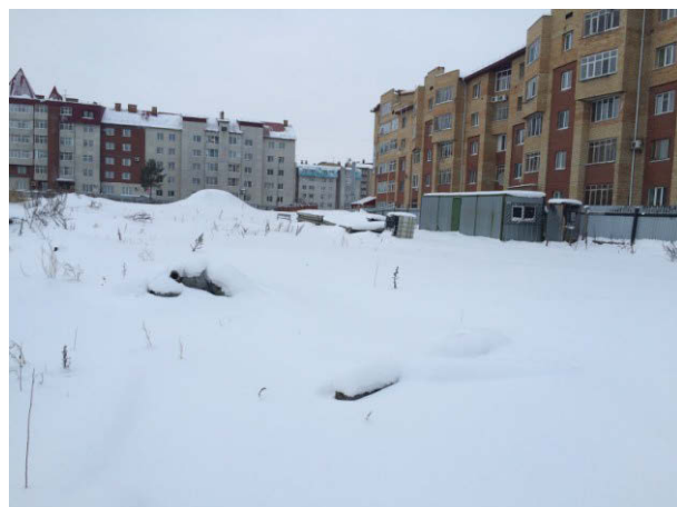
Фото. 4 Внешний вид строящегося жилого дома
