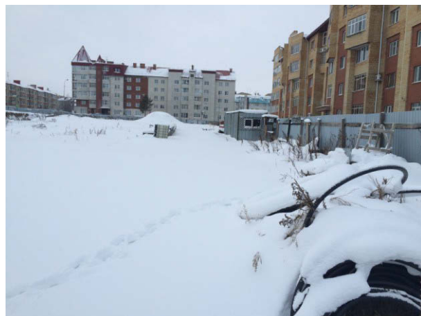
Фото. 2 Внешний вид строящегося жилого дома
