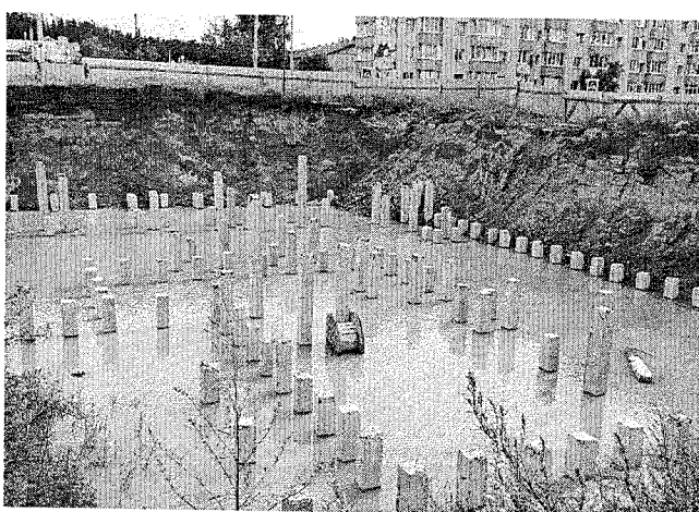
Фото 6. Внешний вид строящегося жилого дома
