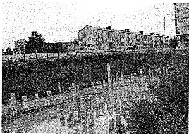
Фото 5. Внешний вид строящегося жилого дома
