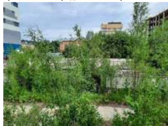
Фото 8. Общий вид объекта незавершенного строительства кадастровый номер: 86:12:0101059:30
