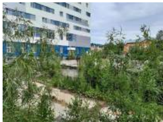
Фото 9. Общий вид объекта незавершенного строительства кадастровый номер: 86:12:0101059:30
