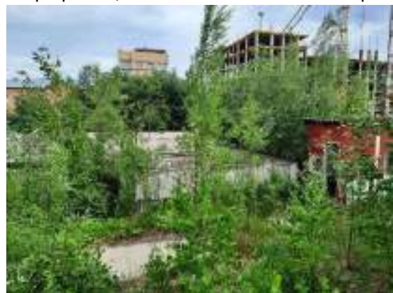
Фото 7. Общий вид объекта незавершенного строительства кадастровый номер: 86:12:0101059:30
