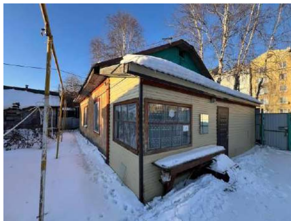
Фото 2. Общий вид жилого дома
