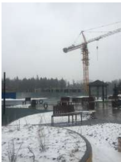
Фото 1. Вид площадки строительства дома
