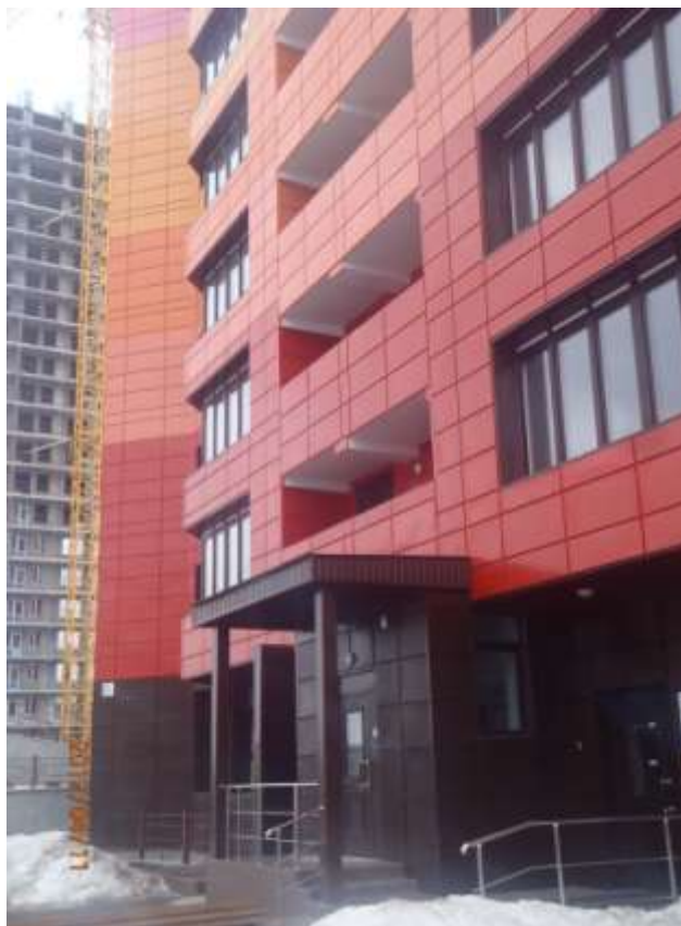
Фото. 1. Внешний вид строительной площадки
