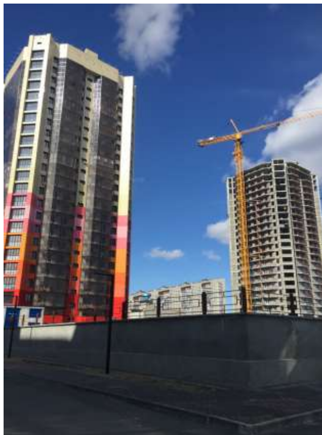
Фото. 2. Внешний вид строительной площадки
