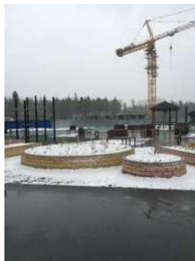
Фото 2. Вид площадки строительства дома
