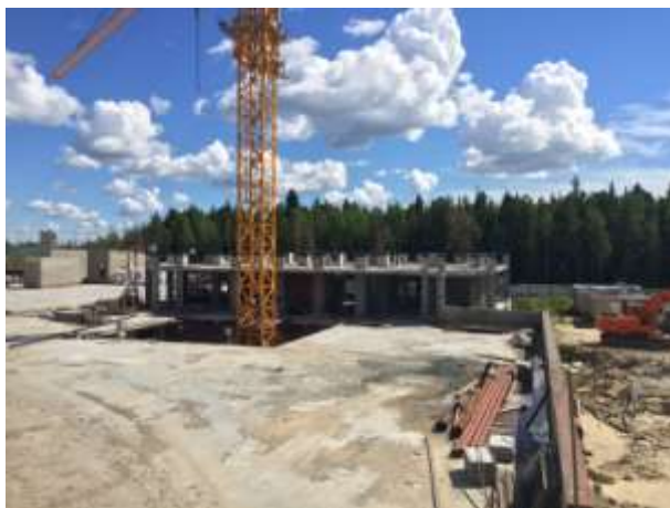
Фото. 5. Внешний вид строительной площадки
