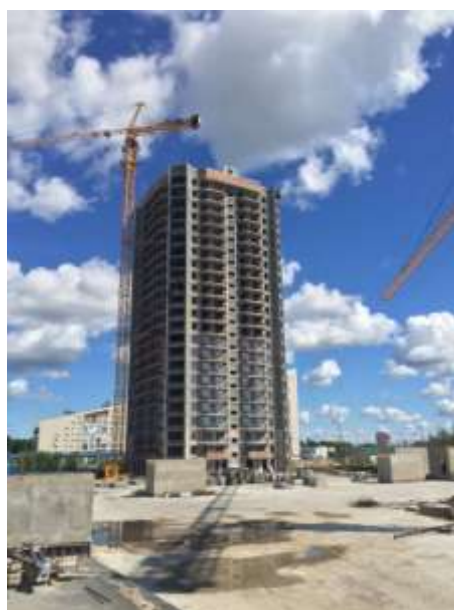
Фото. 4. Внешний вид строительной площадки
