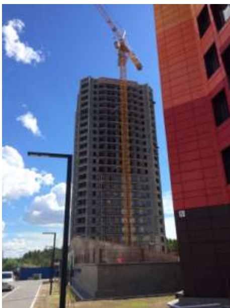
Фото. 1. Внешний вид строительной площадки
