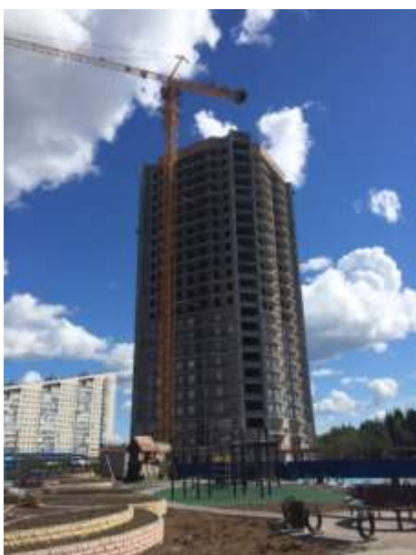
Фото. 3. Внешний вид строительной площадки
