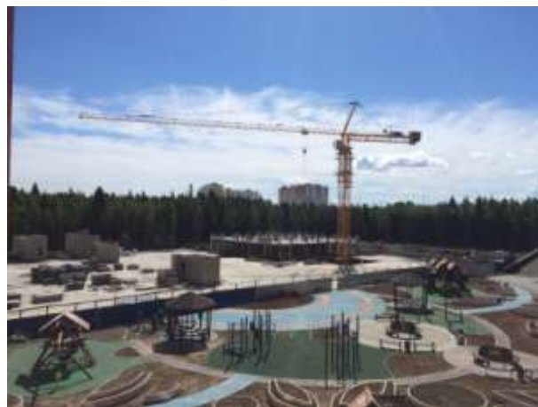
Фото. 6. Внешний вид строительной площадки
