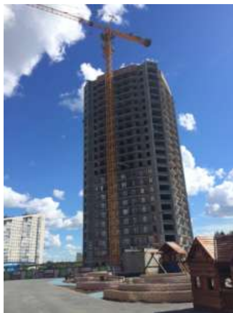
Фото. 2. Внешний вид строительной площадки
