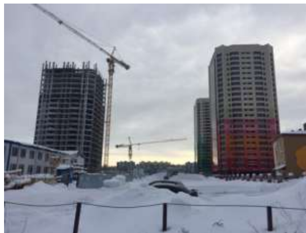
Фото. 2. Внешний вид строительной площадки
