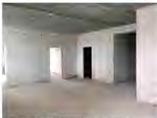
Фото 4. Вид внутри типовой квартиры
